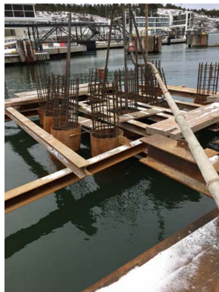
Byggandet av den nya dykdalben vid kaj 4.
