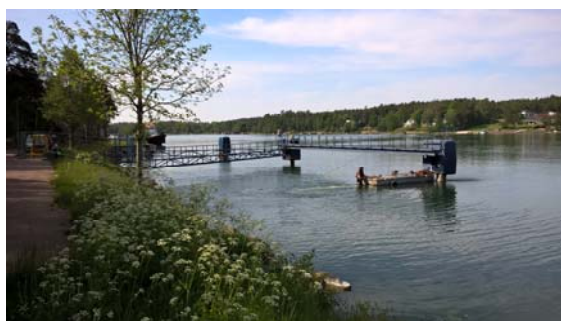
Blästringsarbete vid Kraftverkskajen.
