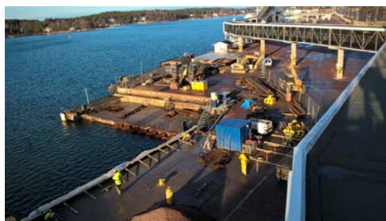
Arbete i full gång vid kaj 4.
