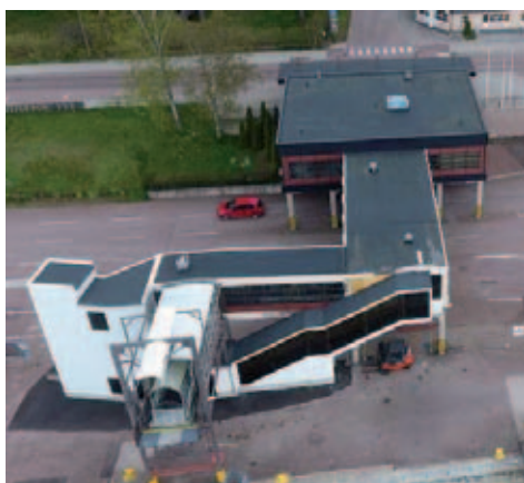
Nybyggt trapphus med hiss vid kryssningsterminalen.
