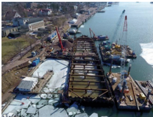
Pommerndockan under konstruktion i mars 2018.
