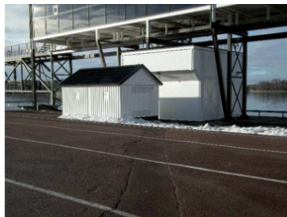
Transformatorstation och traversbyggnad för landströmsanslutning till fartyg vid Kaj 5.
